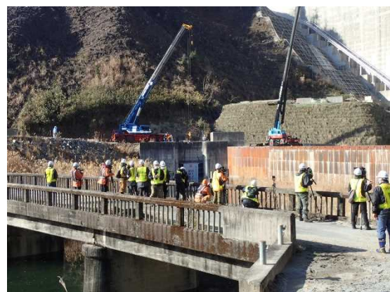
③閉塞作業中
