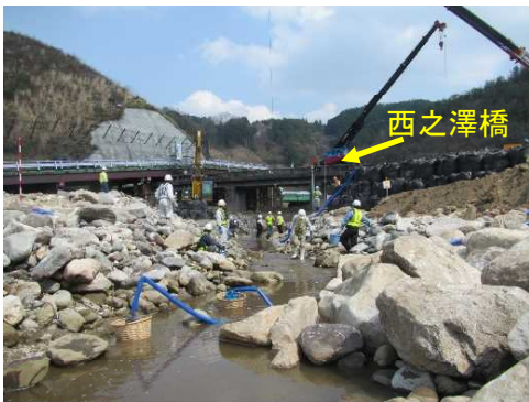
転流直後の堤体区域の調査 (平成30年4月)
