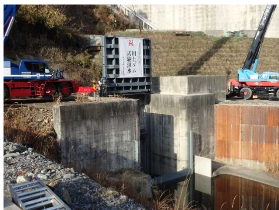
①仮排水路トンネル閉塞前
