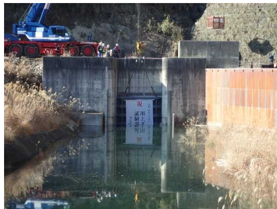
④仮排水路トンネル閉塞後
